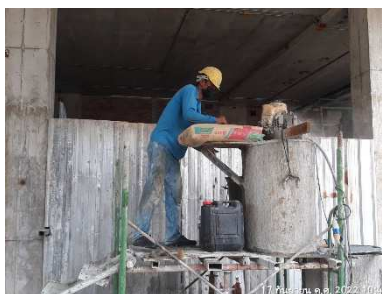
รูปที่ 4 เครื่องผสมน้ำปูน (Grouting Machine)
