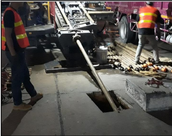
งานต้นก้านเจาะ HDD
