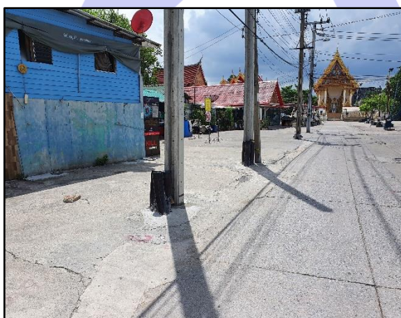
งานจัดท่อขึ้น Riser
