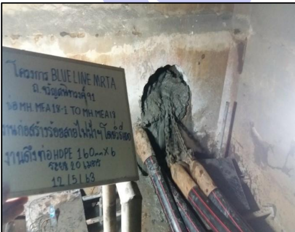
งานติดตั้งท่อ HDPE
