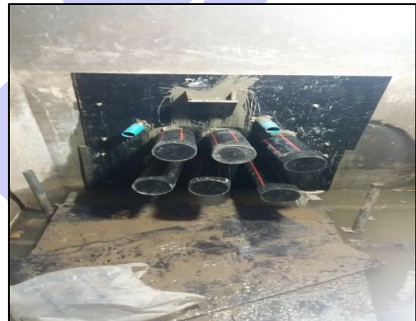
งานแต่งหน้าต่าง และ Grouting
