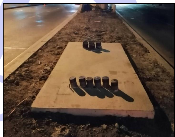
งานก่อสร้างฐาน US.
