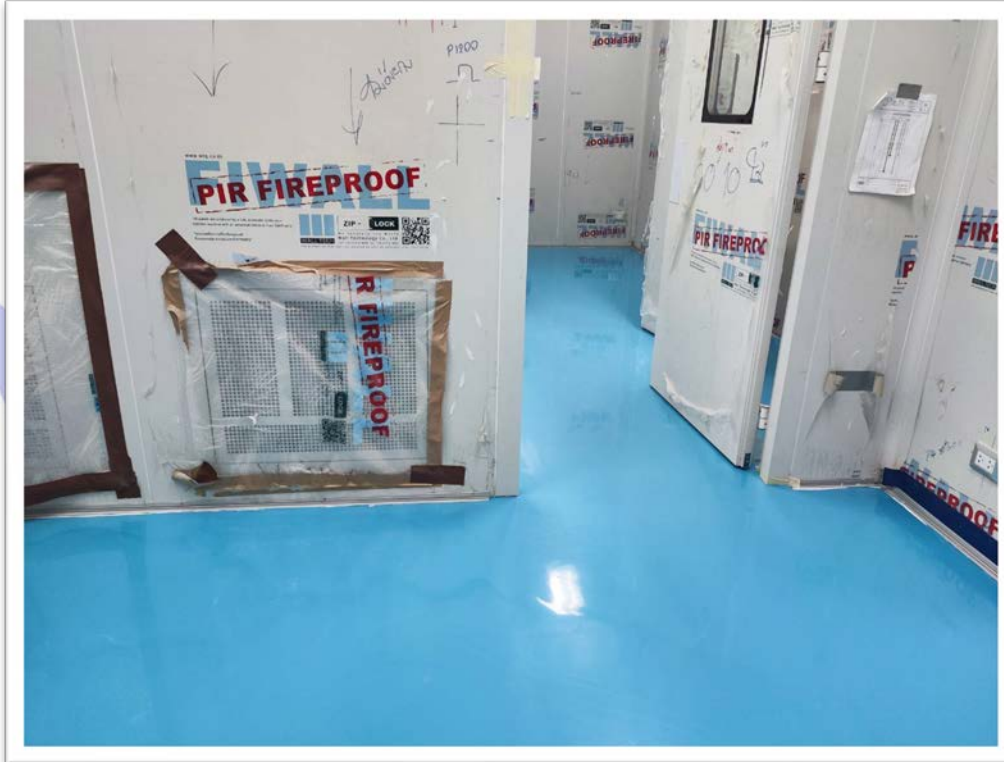
รูปที่ 34. เคลือบผิวพื้นห้องสะอาด ด้วย Epoxy หรือ PU Self – Leveling
