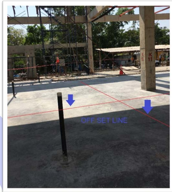
รูป 7. ตัวอย่างการให้ระยะ OFFSET LINE เป็นเส้นอ้างอิง
