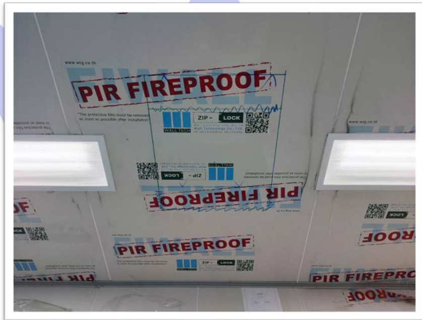
รูปที่ 27. มาร์คตำแหน่งอุปกรณ์ต่างๆ ที่จะต้องเจาะแผ่นทั้งผนังและฝ้า
