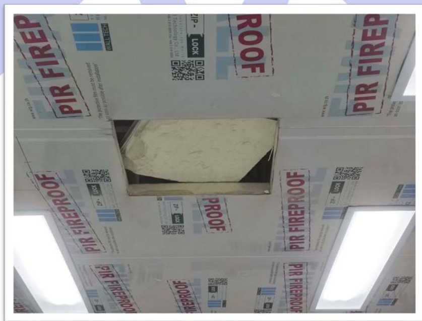
รูปที่ 28. ตัดเจาะแผ่นฉนวนตามตำแหน่งอุปกรณ์ต่างๆ ที่จะต้องเจาะแผ่นทั้งผนังและฝ้า
