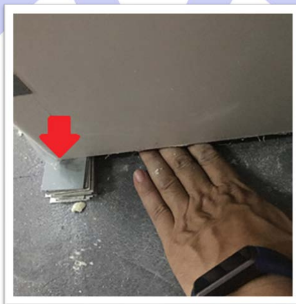
รูปที่ 12. แสดงการใส่แผ่นซีเมนต์ในกรณีที่ระดับพื้นห่าง โดยถ้าค่าระดับแตกต่างกันมาก ทำให้ติดตั้งเส้นฉากไม่ได้ จำเป็นจะต้องแก้ไขปรับระดับพื้นใหม่
