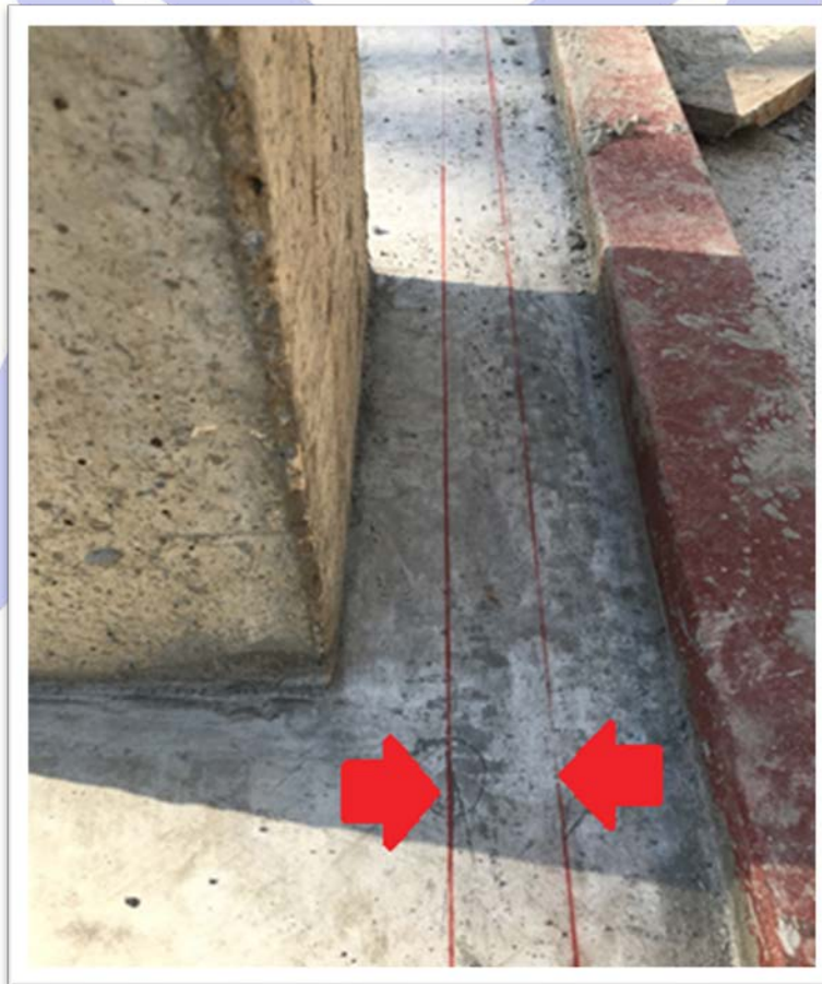
รูปที่ 9. การตีเส้นแนวผนังเส้นคู่ตามขนาดของแผ่นผนังที่จะติดตั้งจริง
