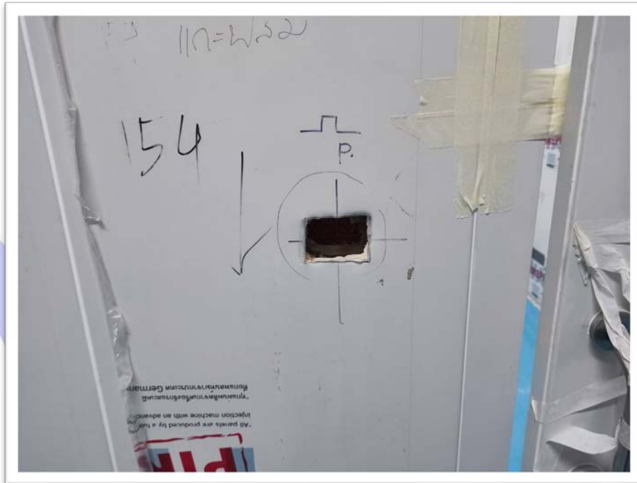
รูปที่ 29. มาร์คตำแหน่งและเจาะแผ่นผนัง สำหรับอุปกรณ์สวิทช์ เต้ารับ
