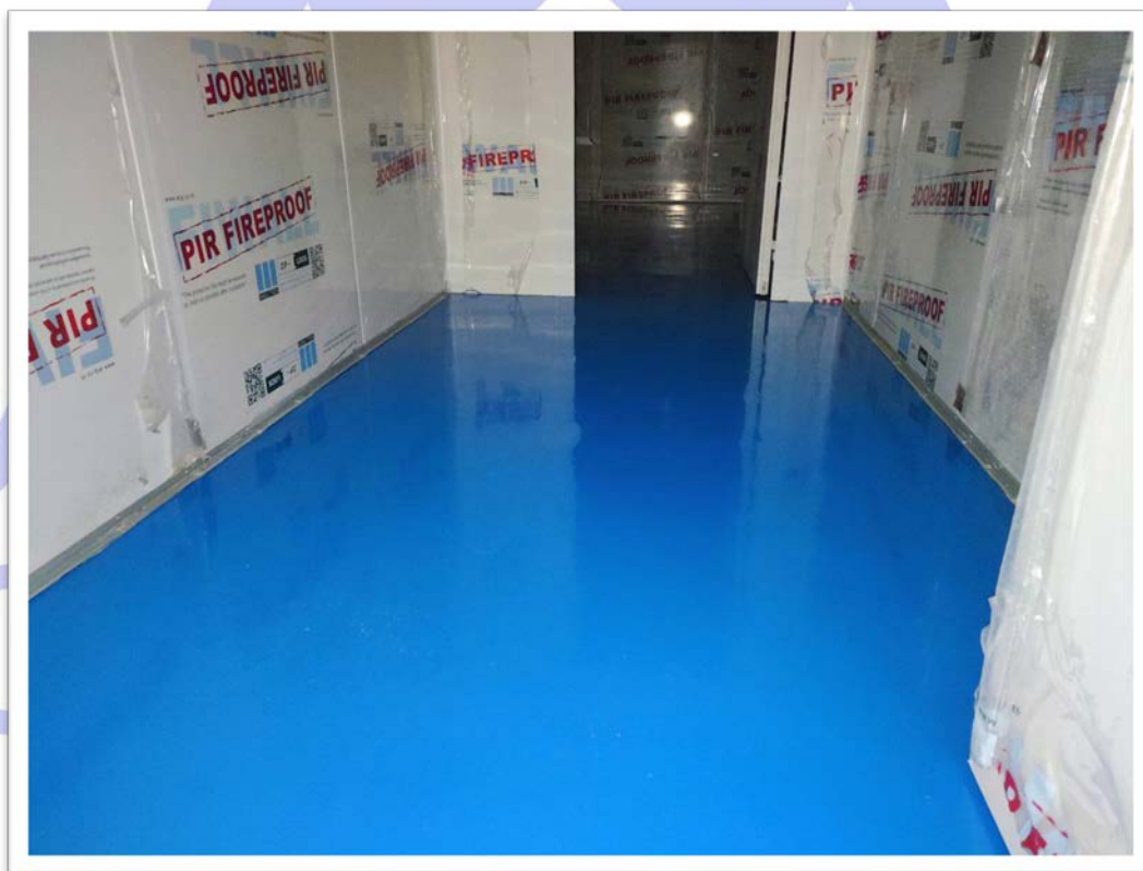
รูปที่ 35. เคลือบผิวพื้นห้องสะอาด ด้วย Epoxy หรือ PU Self – Leveling
