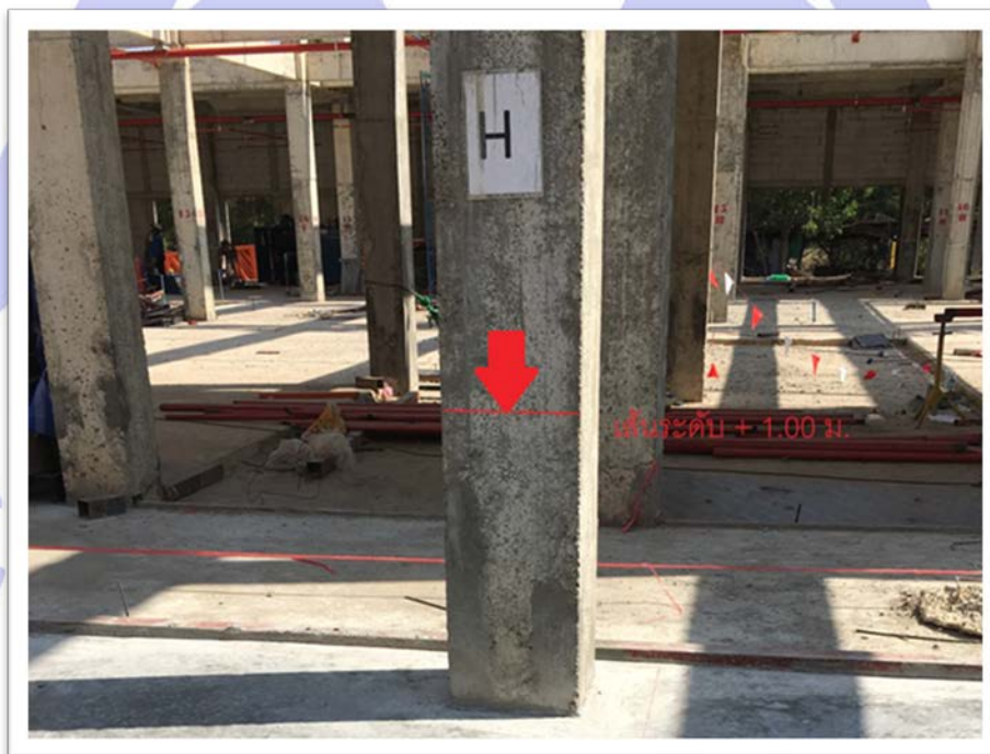
รูปที่ 8. ตัวอย่างเส้นบอกค่าระดับอ้างอิงจากพื้น
