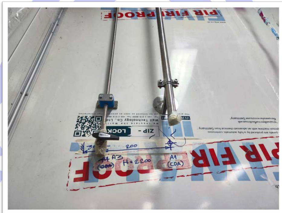
รูปที่ 32. ติดตั้งอุปกรณ์งานระบบน้ำดี และระบบก๊าซที่ใช้งาน
