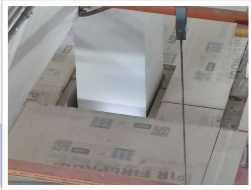
รูปที่ 19. แสดงการติดตั้งแผ่นผ้าบริเวณรอบเสา
