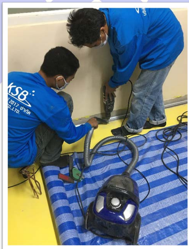
รูปที่ 15. การยืดเส้นฉากอีกด้านที่พื้น เพื่อยึดกับแผ่นผนัง
