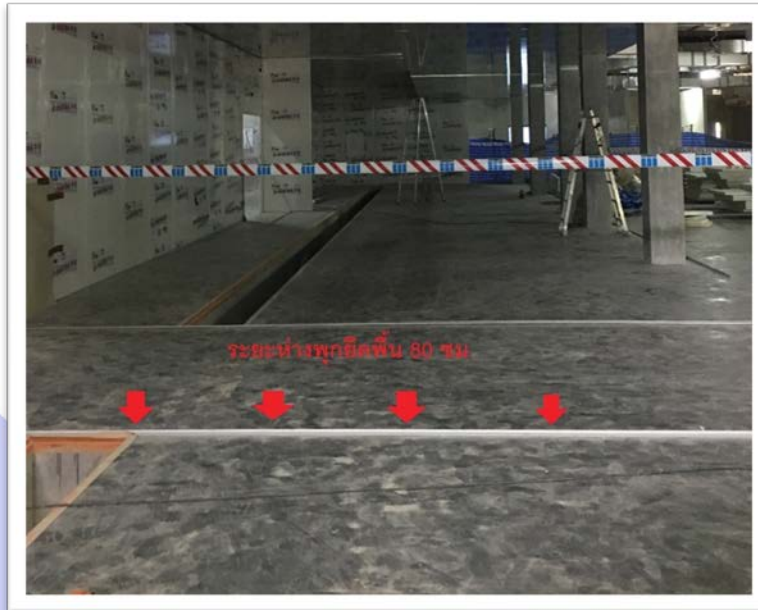
รูปที่ 11. การวางเส้นฉากอลูมิเนียม
