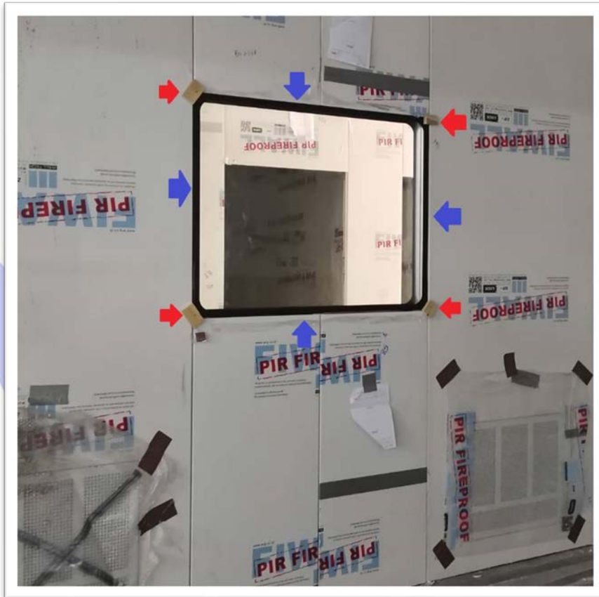
รูปที่ 25. การล้อมคานหน้าต่างเพื่อติดตั้งหน้าต่างกระจก
