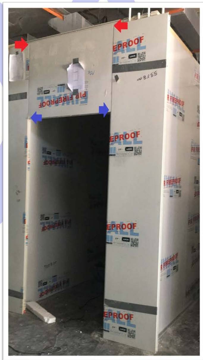
รูปที่ 16. แสดงตำแหน่งยิงรีเวทแผ่นลอยประตู
