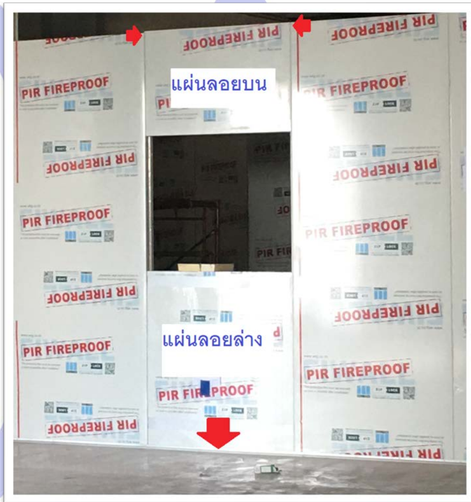
รูปที่ 17 . แสดงตำแหน่งยิงยึดรีเวทแผ่นลอยหน้าต่าง
