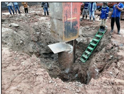
ทำการยกดัมเหล็กตามระยะที่กำหนดและปล่อยกระแทกบนหัวเสาเข็ม
