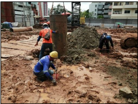
ตรวจสอบตำแหน่งของปลอกเหล็กเบื้องต้น
