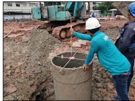
ตรวจสอบตำแหน่งของเสาเข็มเจาะด้วยกล้องสำรวจ(ค่าพิกัด)
