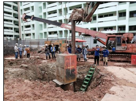
ทำการตรวจสอบแนวดิ่งของดัมเหล็ก
