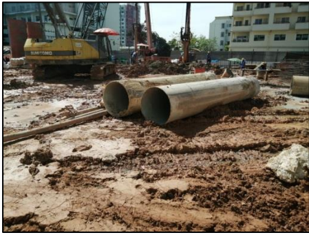
ปลอกเหล็ก(Casing)
