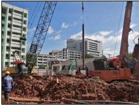
การติดตั้งท่อเทคอนกรีต (Tremie Pipe)
