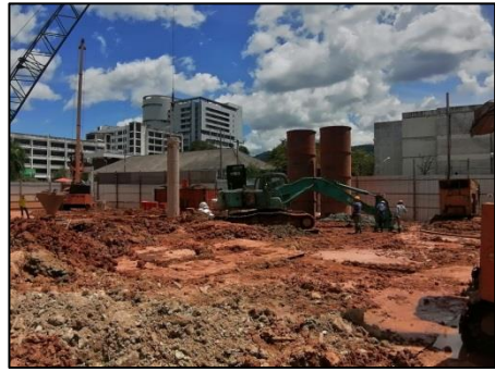
รถแบ็คโฮทำการขุดดินและปักปลอกเหล็ก
