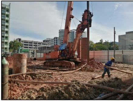
การเจาะโดยใช้หัวเจาะแบบถังหมุน (Bucket)
