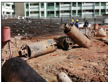
หัวเจาะแบบถังหมุน (Bucket)
