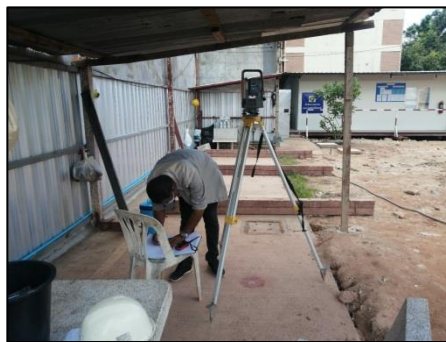
การกำหนดตำแหน่งเสาเข็มโดยกล้องสำรวจ
