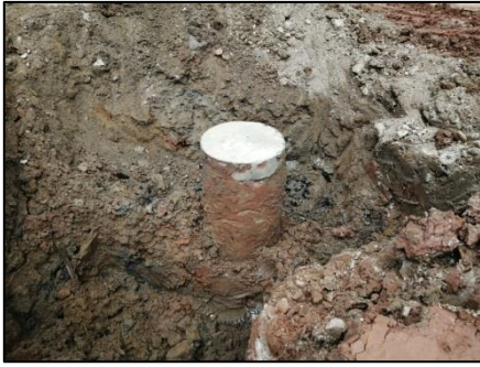
เสาเข็มเจาะที่ทดสอบ
