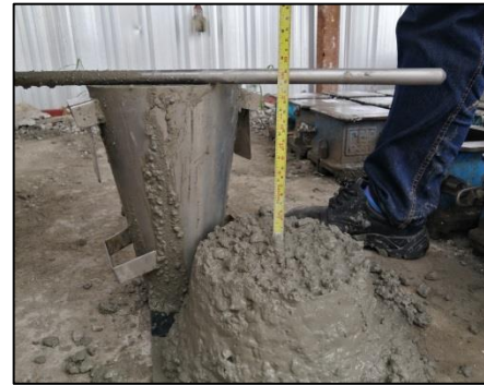
การทดสอบค่าการยุบตัวของคอนกรีต ( Slump Test )
