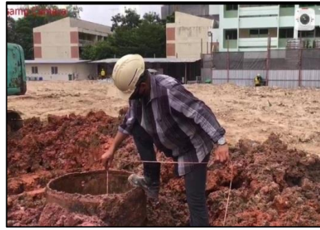
ทำการวัดความลึกของหลุมเจาะสายวัดระยะถ่วงด้วยลูกตุ้ม
