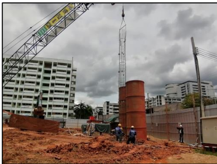
การใส่เหล็กเสริมคอนกรีตลงในหลุมเจาะ
