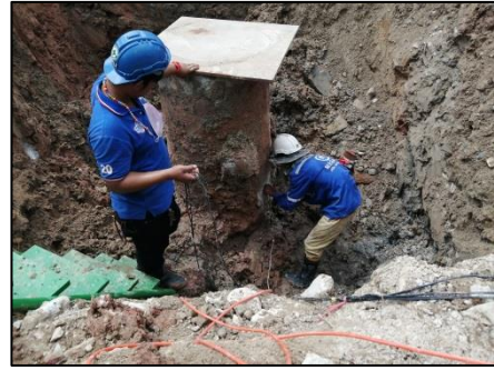
ทำการติดตั้งอุปกรณ์รับสัญญาณ
