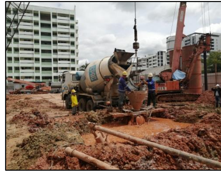
การเทคอนกรีตผ่านกรวยสำหรับเทคอนกรีต
