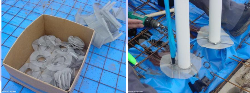
รูปที่ 5 การใช้ตาข่ายกันปลวกหุ้มรอบช่องท่อต่าง ๆ ก่อนเทพื้นคอนกรีต
