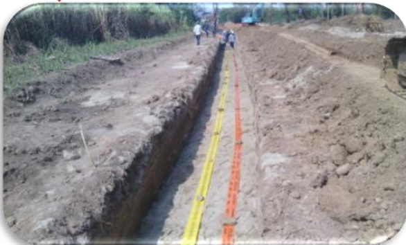
การกลบหน้าดิน วางแผ่นคอนกรีต (Backfill/Concrete)
