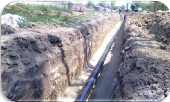
การวางท่อลงสู่ร่องขุด (Lowering in)
