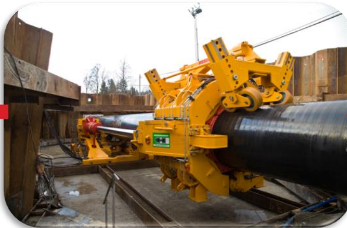
ทำการดันท่อด้วยระบบไฮดรอลิก
