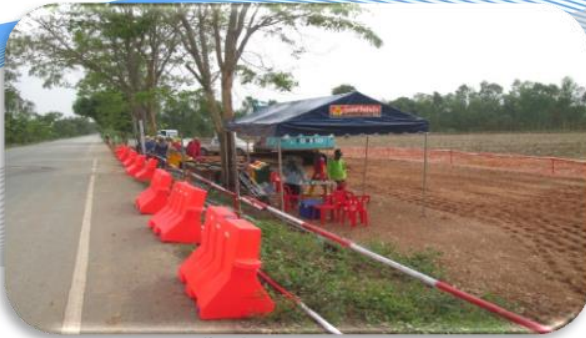
ปรับสภาพพื้นที่ (Clearing & Grading)
