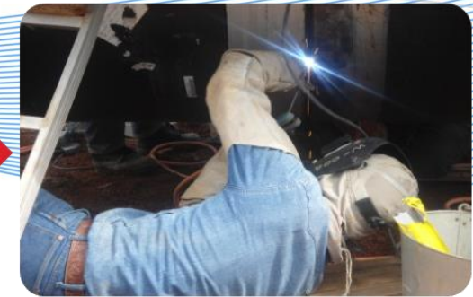
การเชื่อมท่อ (Welding)
