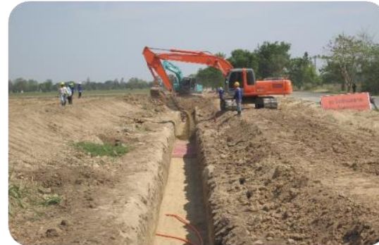
การขุดเปิดหน้าดิน (Trenching)
