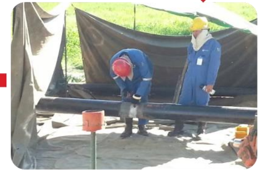
การหุ้มรอยเชื่อมท่อ (Fill Joint Coating)
