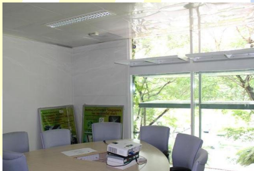
การใช้หิ้งสะท้อนแสง (light shelf) ที่ตอนบนของหน้าต่างและฝ้าเพดานที่มันเงา เพื่อช่วยสะท้อนแสงเข้าสู่ด้านในอาคารได้มากขึ้น
