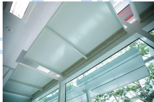
การใช้หิ้งสะท้อนแสง (light shelf) ที่ตอนบนของหน้าต่างและฝ้าเพดานที่มันเงา เพื่อช่วยสะท้อนแสงเข้าสู่ด้านในอาคารได้มากขึ้น
