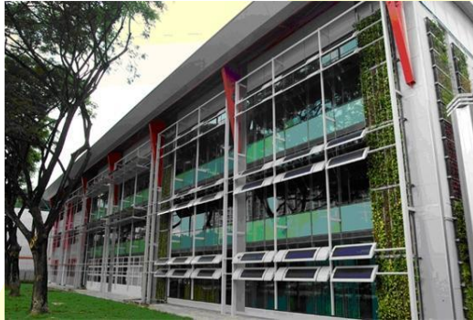
การใช้ PV แบบ thin film amorphous ร่วมกับอุปกรณ์บังแดด
