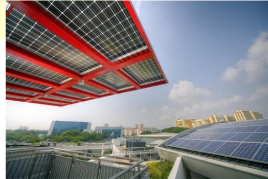
การใช้ PV glass แบบ Mono crystalline (ด้านซ้าย) และแผงแบบ Polycrystalline (ด้านขวา)
