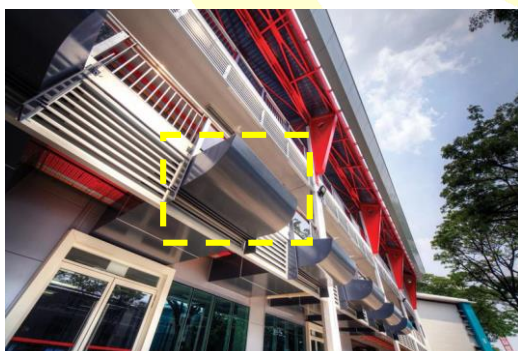
การใช้ท่อนำแสงแนวนอนจากด้านข้าง เข้าสู่พื้นที่กลางอาคาร
