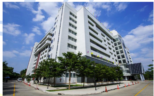
ภาพที่ 2 : ลักษณะอาคารที่มีอยู่เดิมที่นำมาศึกษาปรับปรุงอาคาร
