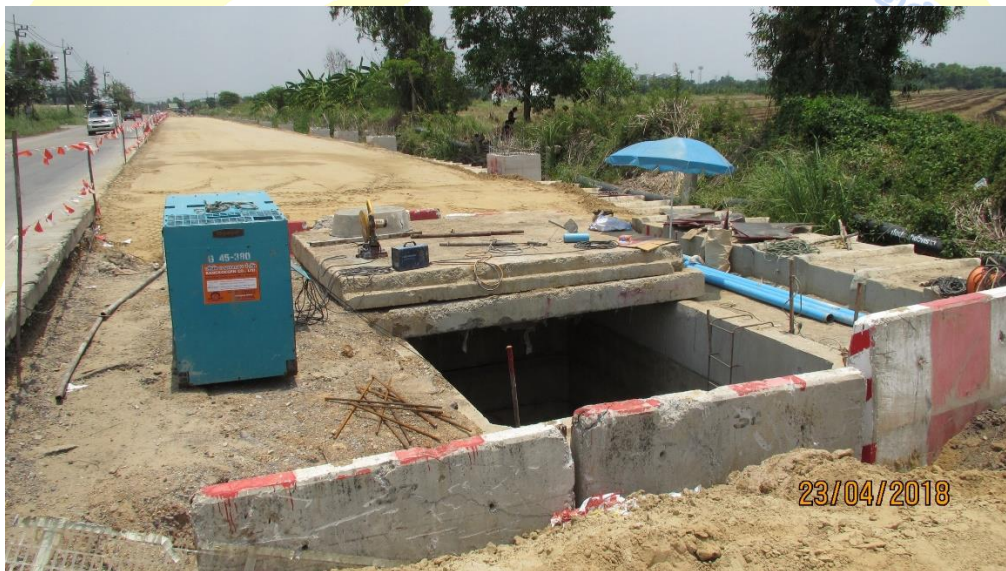
แผ่นคอนกรีต ปิดฝาบ่อพักชั่วคราว
