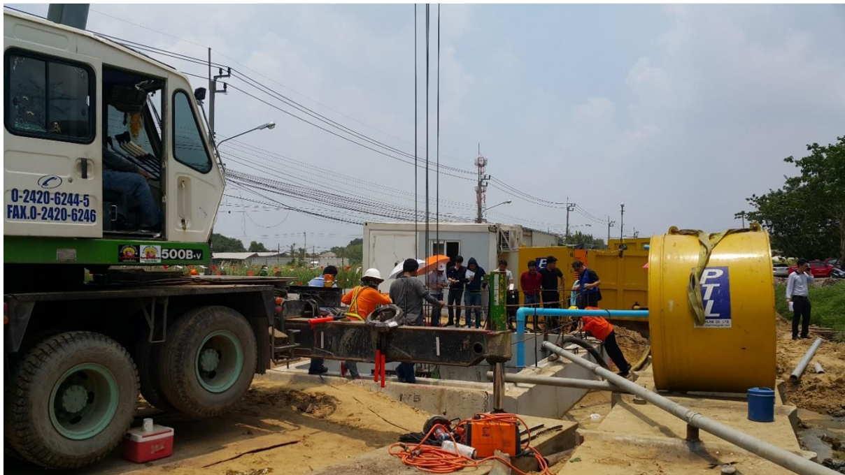
กิจกรรมการดันท่อ Pipe Jacking
