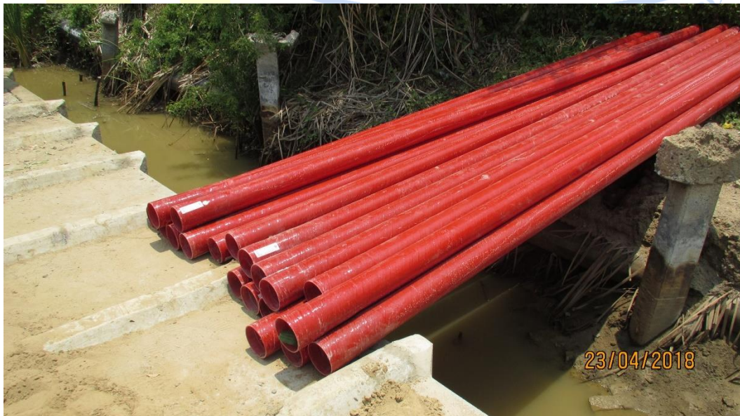
ท่อร้อยสาย RTRC (Reinforce Thermosetting Resin Conduit)
