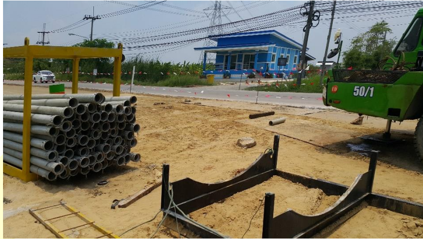
ท่อส่งดินและน้ำ ที่เกิดจากการดันท่อลอด
