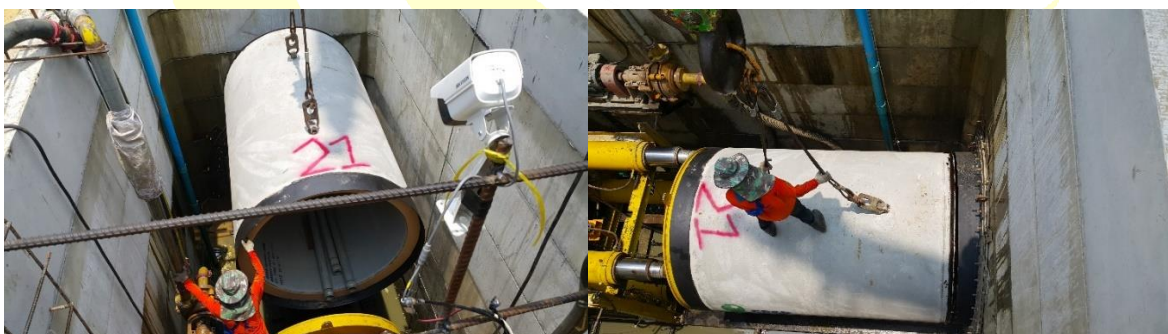
นำท่อ ค.ส.ล ลงในบ่อพัก เพื่อเตรียมการดันท่อ
